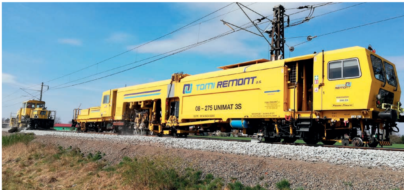
Strojní linka při úpravě prostorové polohy koleje
