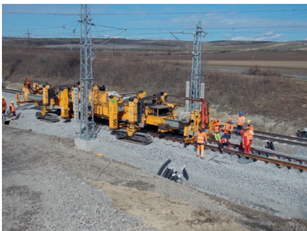
Pokládka kolejí a výhybek v žst. Šakvice
