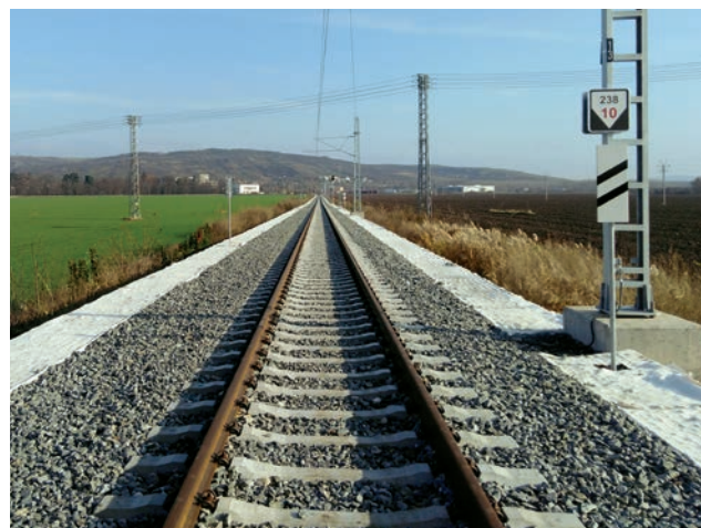
Traťový úsek Hrušovany – Židlochovice po dokončení rekonstrukce
