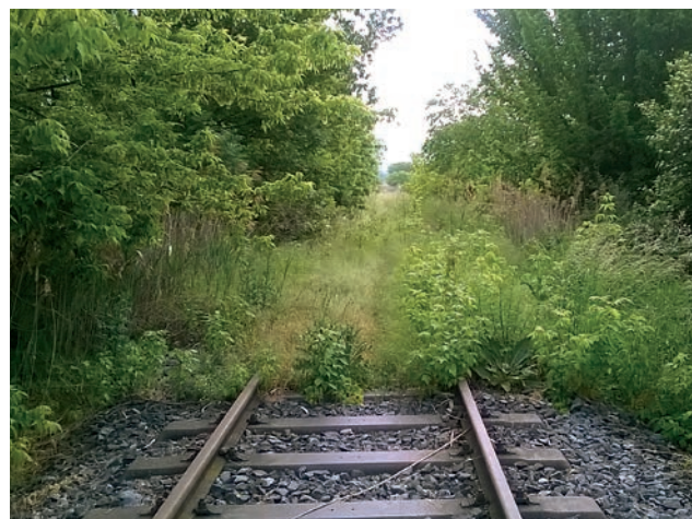
Traťový úsek Hrušovany – Židlochovice před zahájením rekonstrukce
