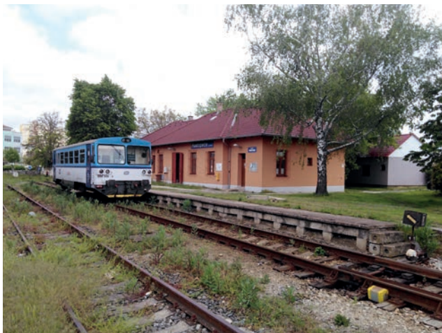
Žst. Hustopeče u Brna před zahájením rekonstrukce
