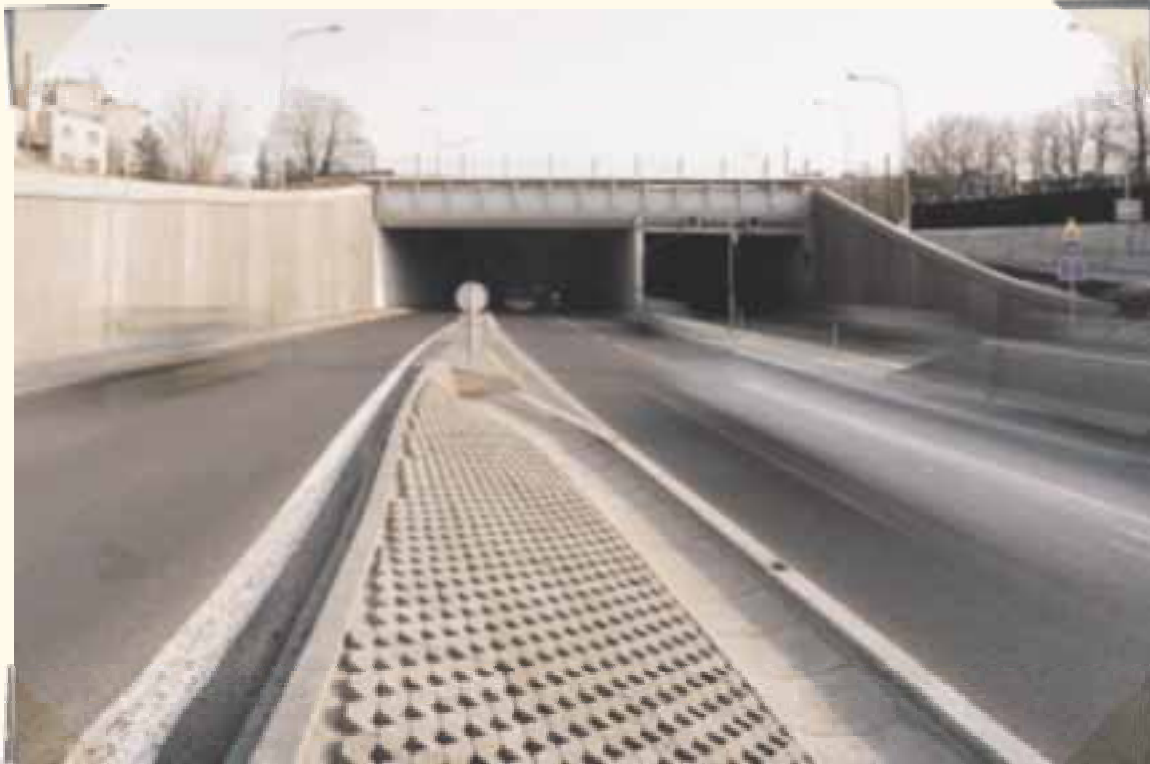
Velký městský okruh Kohoutova, tunel Kohoutova great urban ring, tunnel
