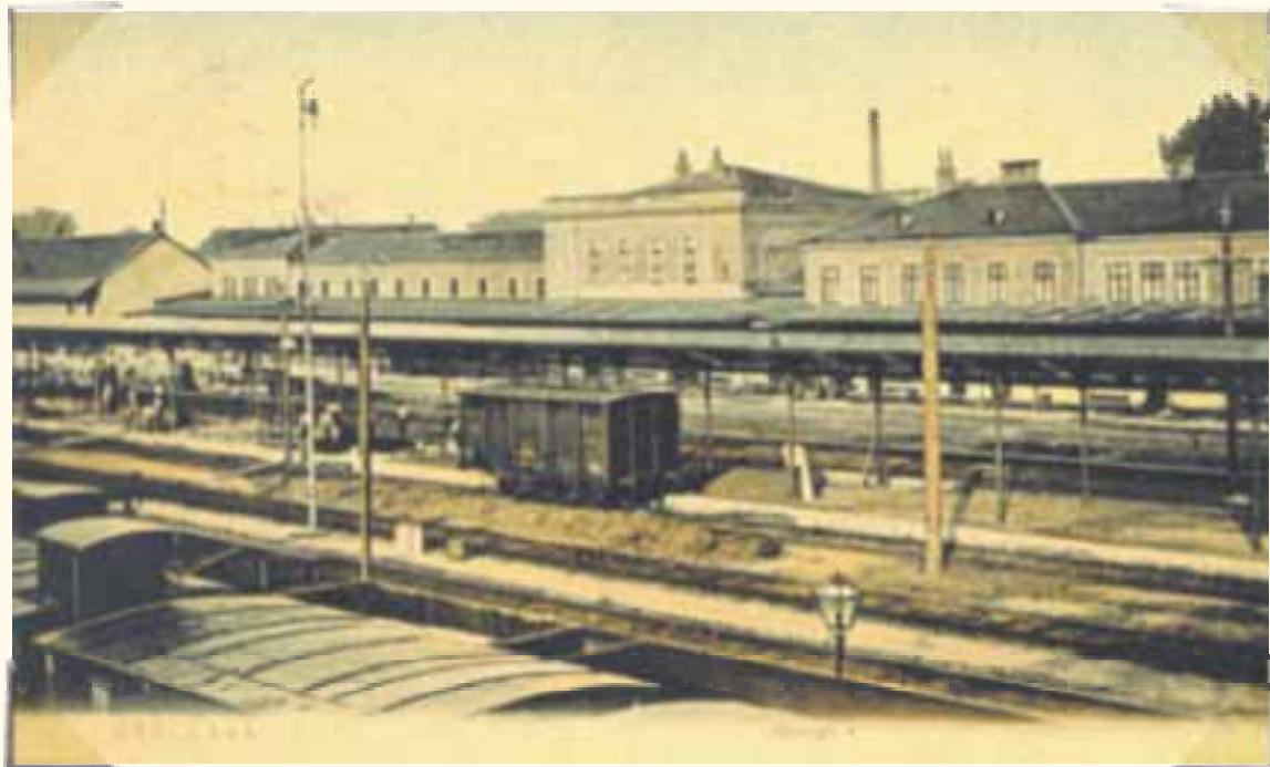
Žel. stanice Břeclav, 1928 Břeclav railway station, 1928
