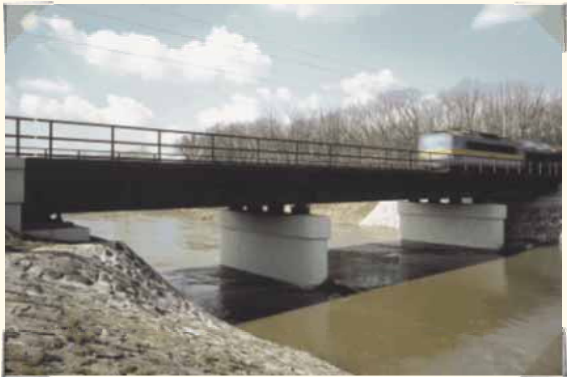
Modernizace trati st. hranice Rakousko-Břeclav-Vranovice, most přes řeku Svatku Modernization of Austrian state border-Břeclav-Vranovice railway track, bridge across the Svatka river
