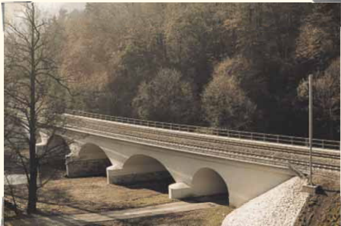
Optimalizace trati Brno-Skalice nad Svitavou, pětiklenbový most přes řeku Svitavu Optimising of Brno-Skalice nad Svitavou railway track, five-arched bridge across the Svitava river
