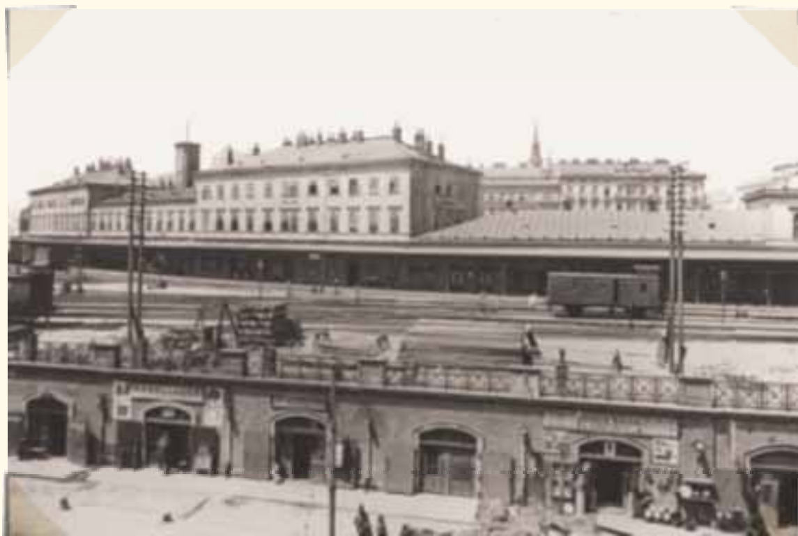
Žel. stanice Brno, hl. nádraží, výpravní budova Brno main railway station, station building
