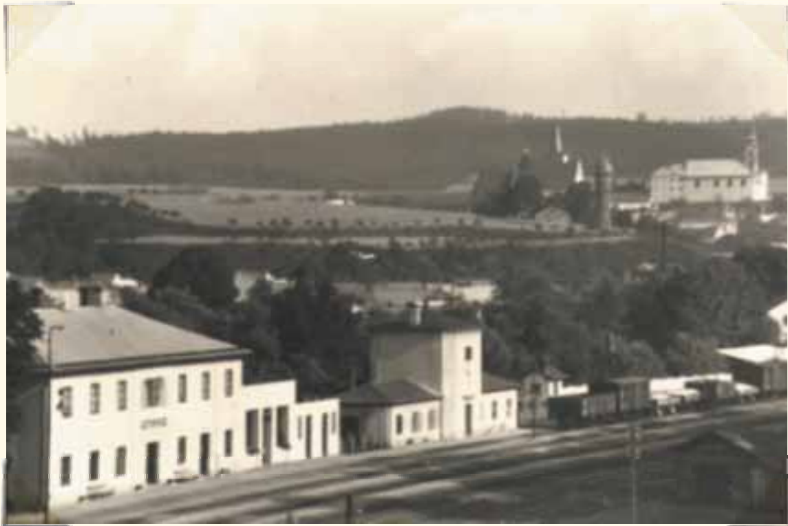
Žel. stanice Letovice, traťový úsek Brno-Česká Třebová Letovice railway station, Brno-Česká Třebová track section
