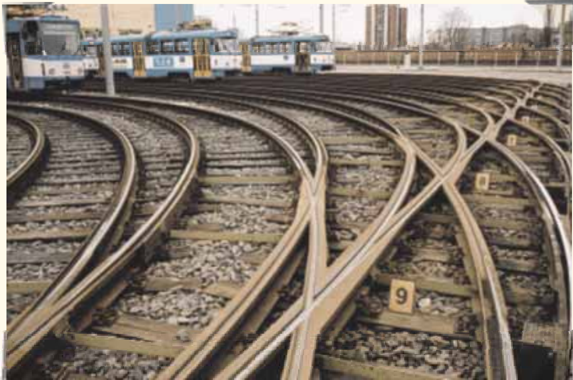
Rekonstrukce tramvajové vozovny v Mor. Ostravě, ulice Křivá Reconstruction of the tramway depot in Moravská Ostrava, Křivá Street
