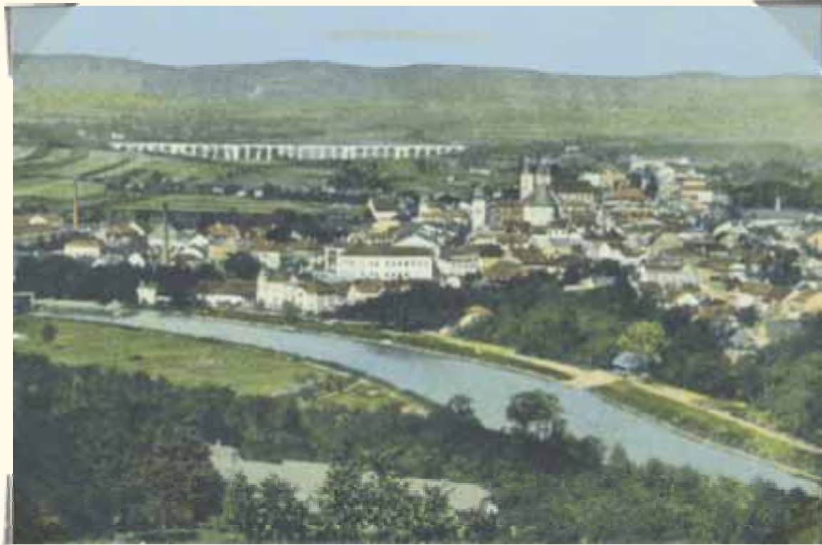
Hranický viadukt Hranice viaduct
