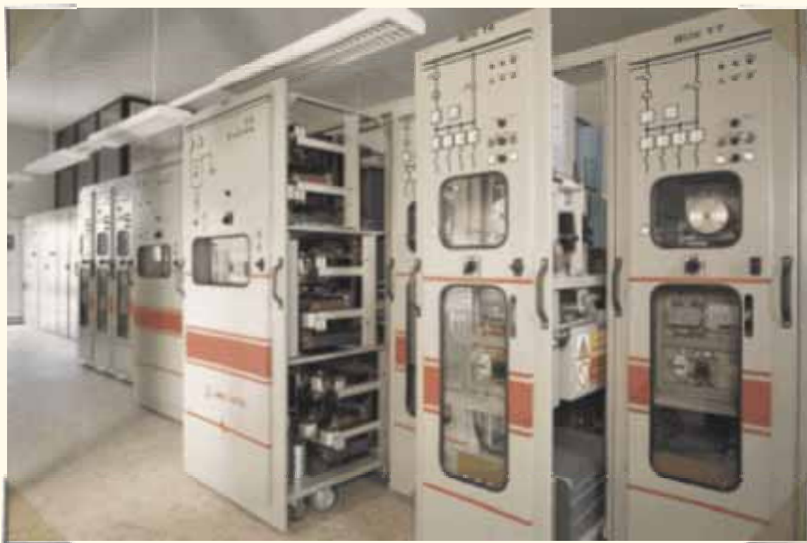
Stejnoseměrný napájecí rozvaděč pro dopravní podniky DC power supply distribution plant for transport enterprises
