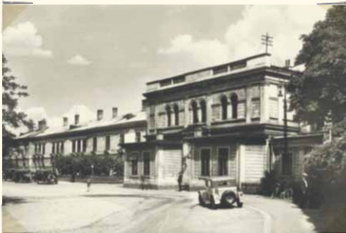
Žel. stanice Břeclav, 1930 Břeclav railway station, 1930
