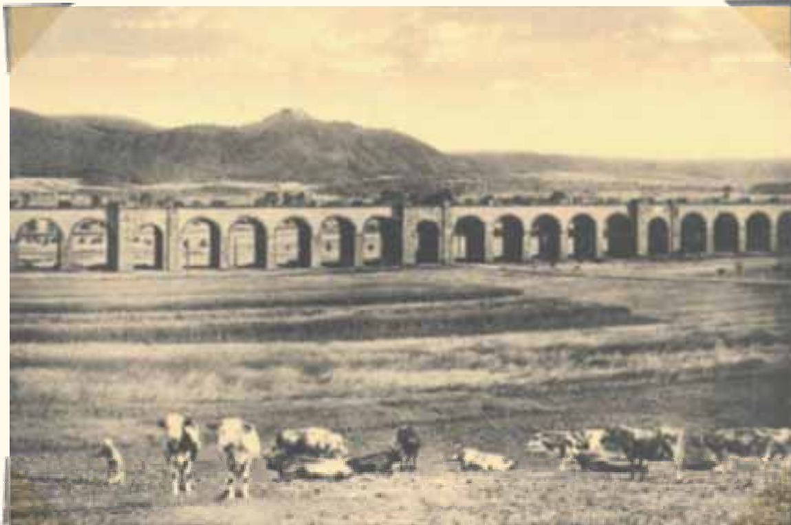
Jezernický viadukt Jezernice viaduct
