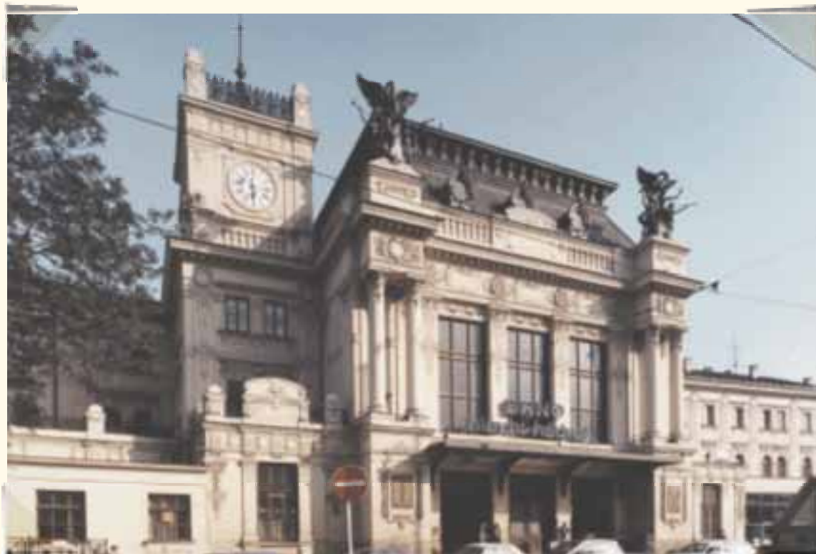
Rekonstrukce hlavního nádraží v Brně Reconstruction of Brno main railway station
