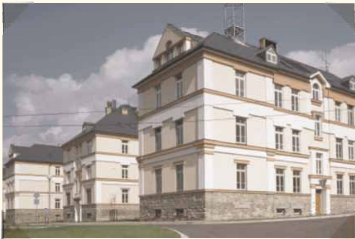
Rekonstrukce Okresního ředitelství Policie ČR, Jeseník Reconstruction of the District Headquarters of the Czech Police, Jeseník
