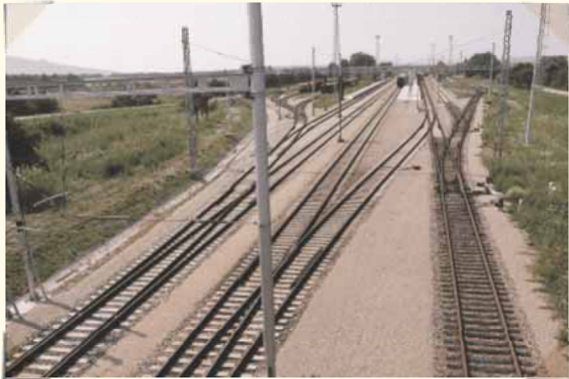
Modernizace trati st. hranice Rakousko-Břeclav-Vranovice, žel. stanice Zaječí Modernization of Austrian state border-Břeclav-Vranovice railway track, Zaječí railway station
