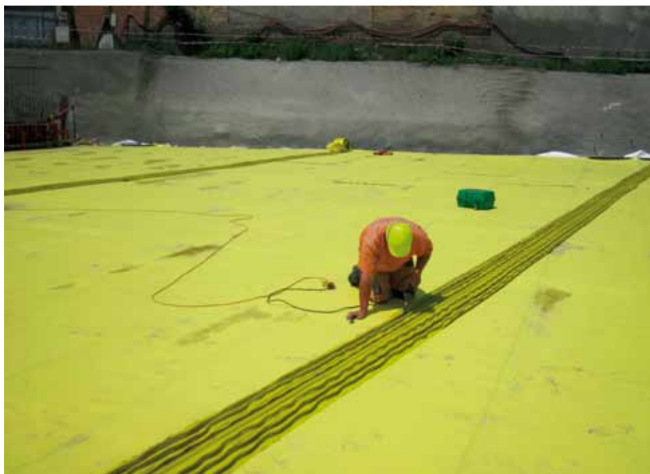
❖ Protivztlaková vana, Brno: navaření dilatačního pásu na fólii
