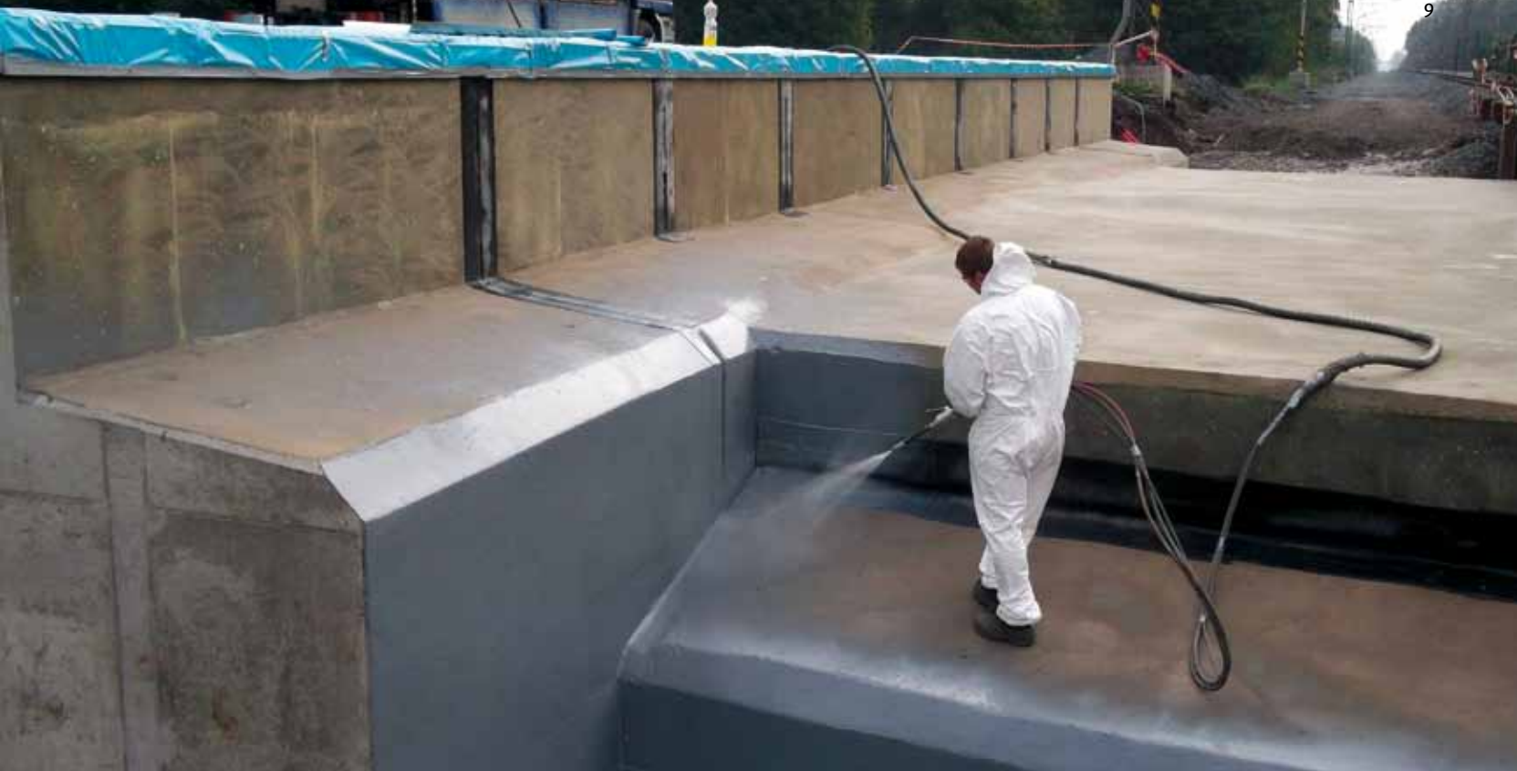
Most v Třinci: provádění nástřiku PUR izolace ❖
