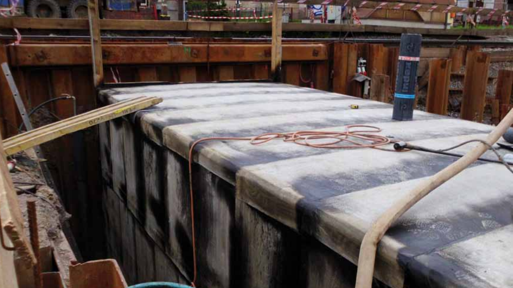
Podchod ve Vendryni: tlaková izolace z asfaltových pásů
