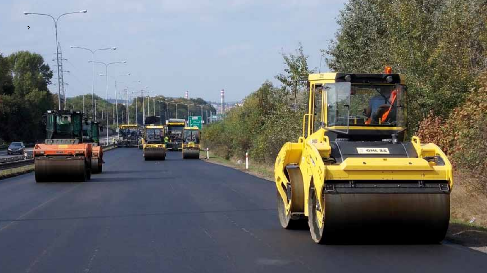
Finální úprava povrchu vozovky na ulici Ostravská v Brně
