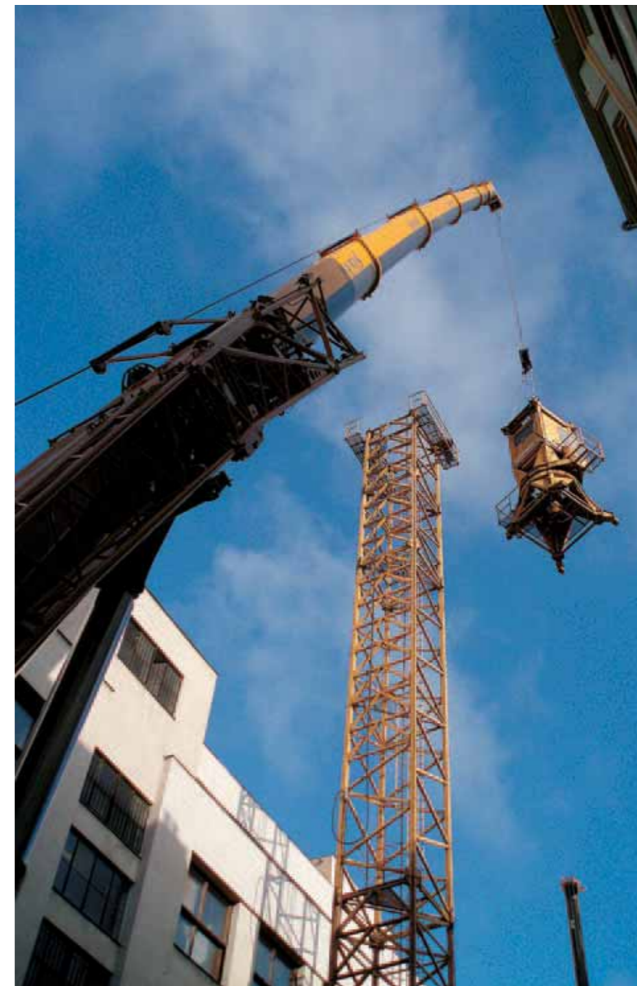
Klíčovou roli hraje při prostorově omezených možnostech stavby jeřáb, smontovaný v Balbinově ulici.
