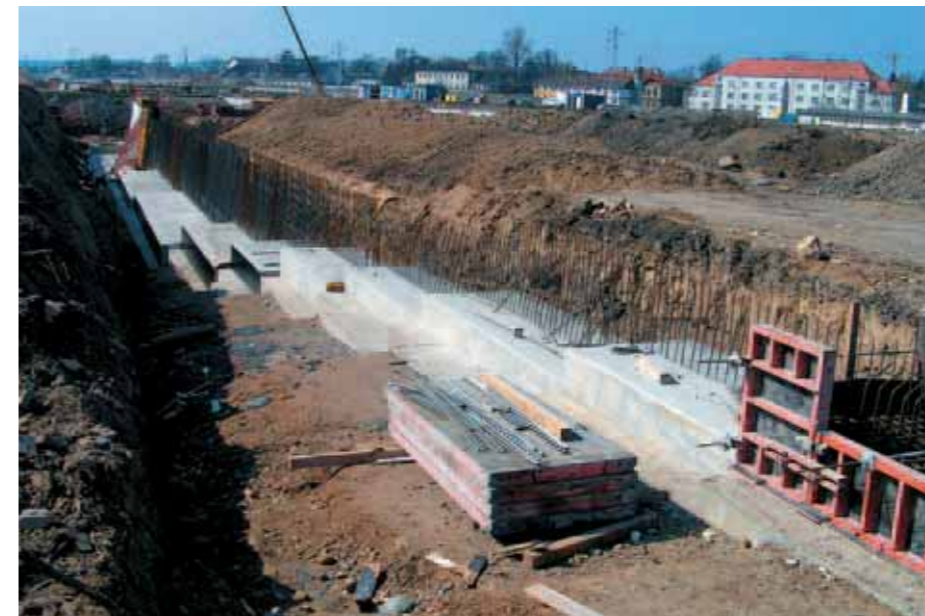
Základy opěrné zdi SO 01-19-21.2
