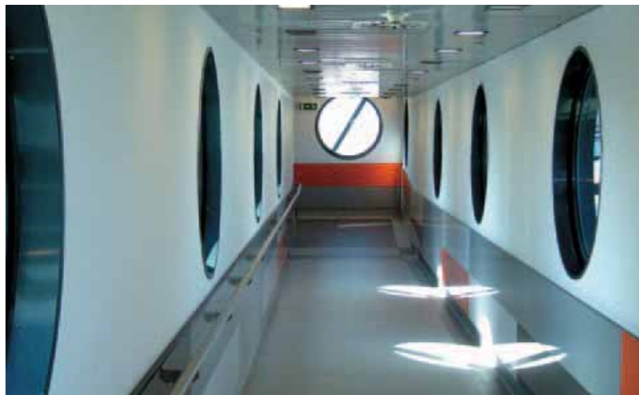
Vnitřek přístupové chodby k pasažérskému nástupnímu mostu
