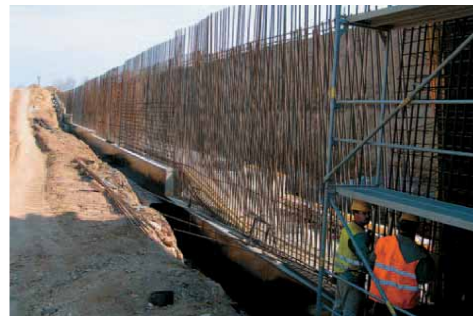
Montáž armatury dříků opěrné zdi SO 01-19-21.2
