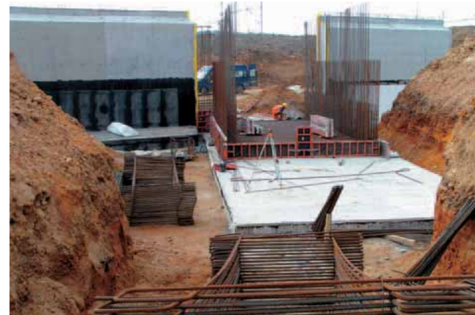
Příprava betonáže dna tubusu mostního objektu SO 01-19-13
