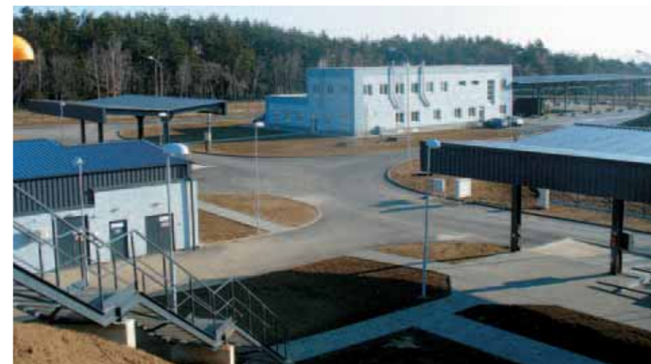
Provozní budova, přístřešek pro AC 24 stání a výdejní stáčiště AC
