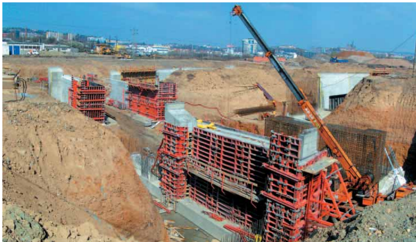
Výstavba mostních objektů SO 01-19-08, SO 01-19-11 a SO 01-19-12 budoucího podjezdu na ul. Košuličova
