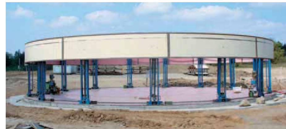
Montáž ocelové nádrže o objemu 1 000 000 litrů
