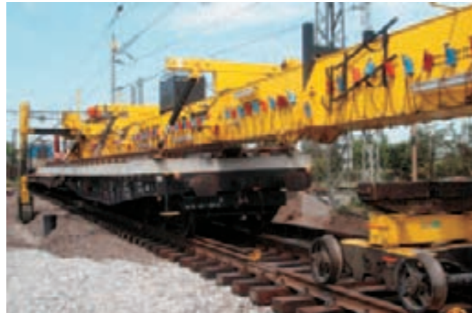
Pokládka výhybek na betonových pražcích
