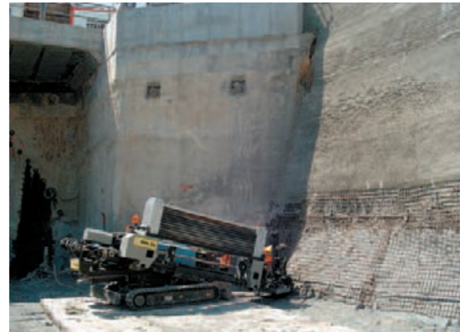
VMO Dobrovského B, zajištění stěn stavební jámy Královo Pole hřebikováním a stříkaným betonem
