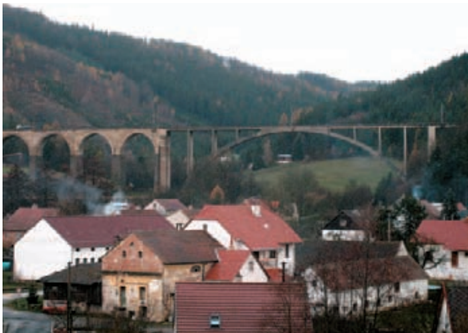
Pohled na železniční most v Dolních Loučkách v rekonstruovaném úseku mezi stanicemi Tišnov a Říkonín
