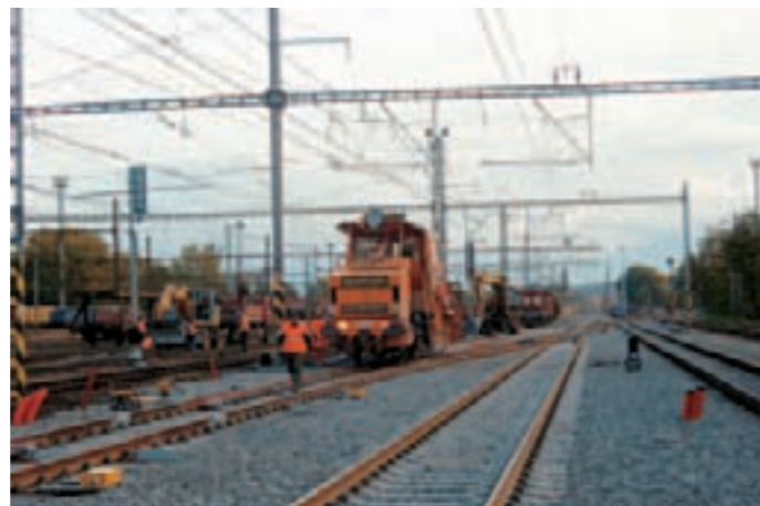
Úprava šterkového lože v kol. č. 2 - poslední výjuka 2007
