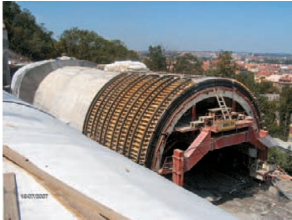
Praha - Nové spojení, betonáž jižního portálu železničního tunelu
