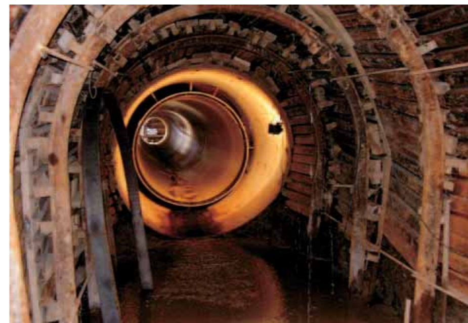
Vyražená štola klasickým způsobem a vystrojení sklolaminátovým potrubím
