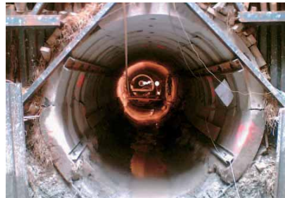
Štola vyražená tunelovacím strojem - štít 2560 mm, montované ostění štoly ze železobetonových segmentů - klenáku
