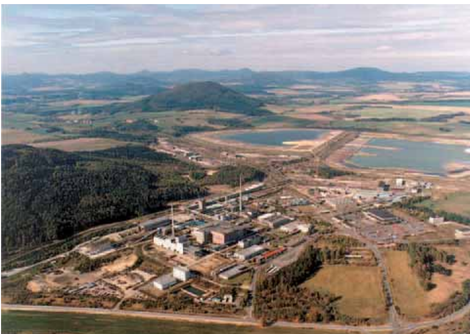
Letecký pohled na odštěpný závod Těžba a úprava uranu státního podniku DIAMO s vyluhovacími poli v pozadí
