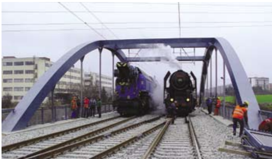
Zaléžkávací zkouška mostu přes Západní okruh
