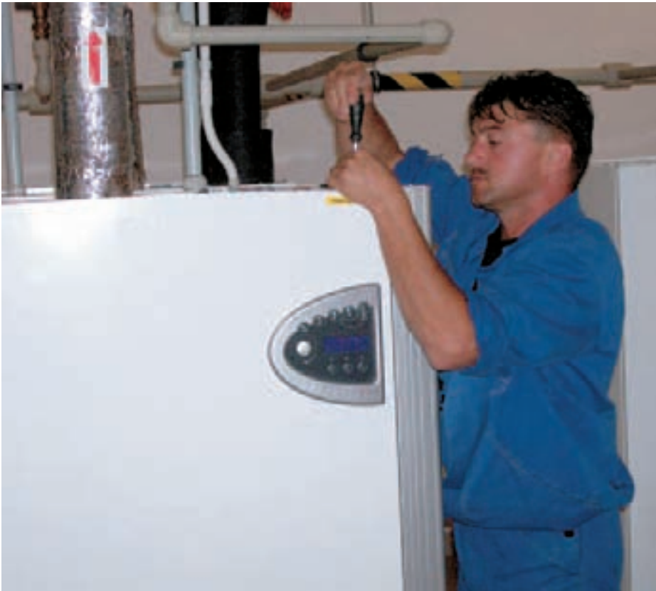
Realizátor zakázky, instalatér Juraj Kaško při zapojování jednoho z tepelných čerpadel
