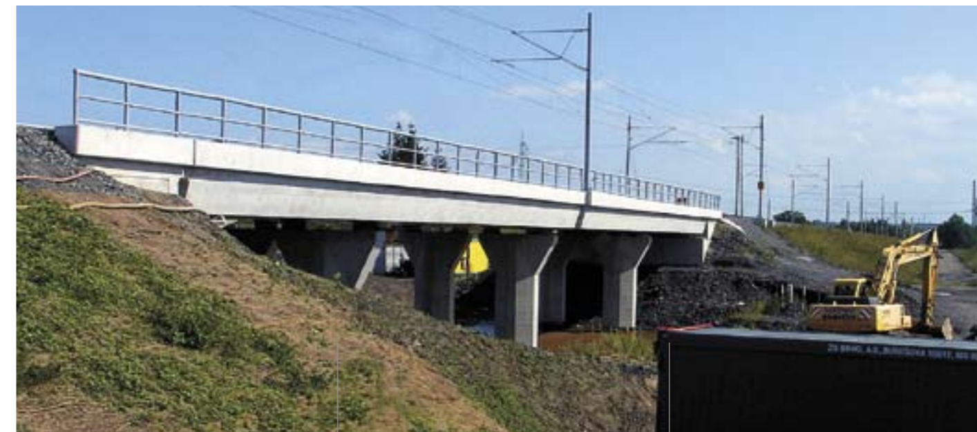
Železniční mostní objekt SO 208 - stav po provedení hlavní prohlídce, zaléžovací zkouška a spuštění zkušebního provozu v srpnu 2006
