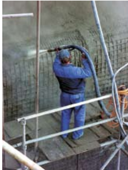
Reprofilace stříkaným betonem
