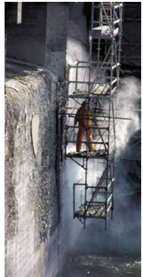
Tryskání povrchu na přelivových hraních hráze
