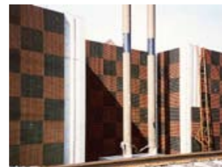
Protihluková stěna PHS 2
