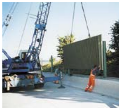
Montáž panelu SILENT pomocí autojeřábu - Tautendorf SRN
