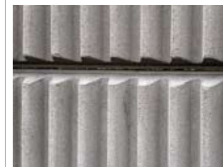
Detail styku panelů SILENT
