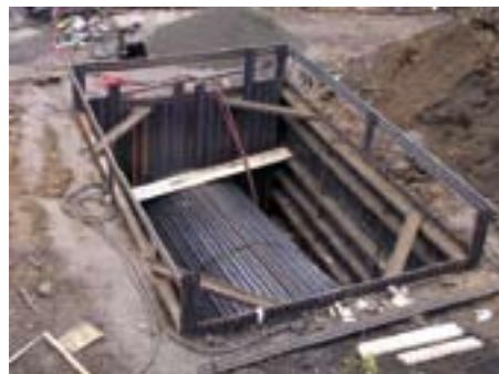
Obr. č. 3 - z výstavby výztuže kolektoru v Š3
