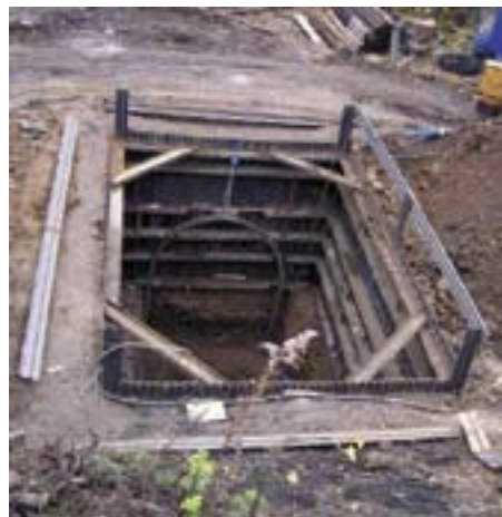
Obr. č. 2 - osazení prvního sruhu výztuže štoly v Š3
