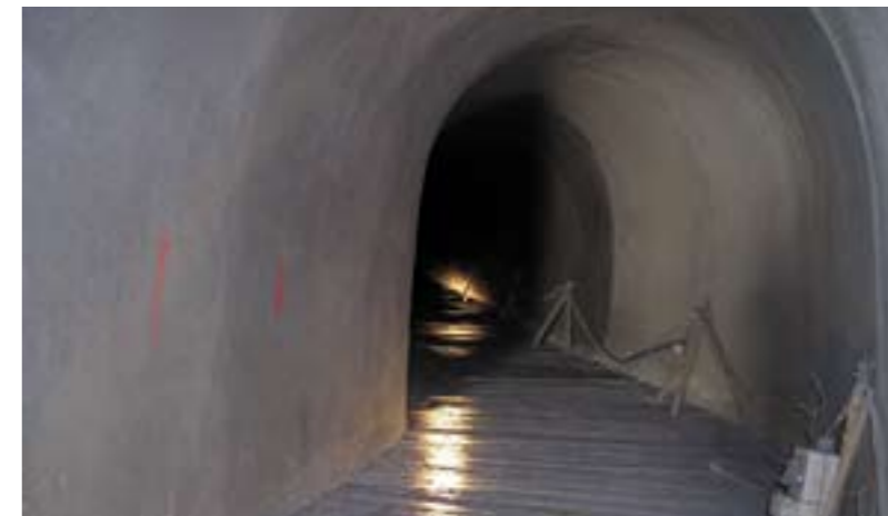
Obr. č. 8 - kolektor před vystrojením OK
