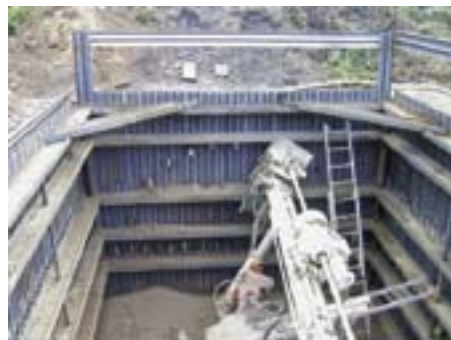
Obr. č. 1 - osazení MP z Š3 pod železniční trati
