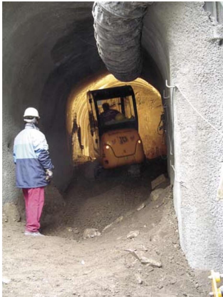
Obr. č. 5 - začátek ražby pod trati Masarykovo nádraží - Libeň
