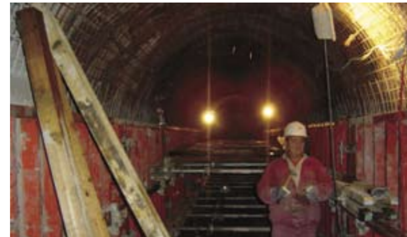
Obr. č. 7 - bednění na lité beton stěny kolektoru
