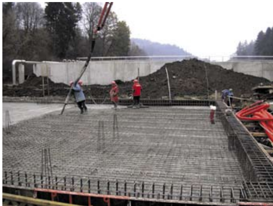
Betonáž základové desky pro linku termické degradace odpadů/ spalovna
