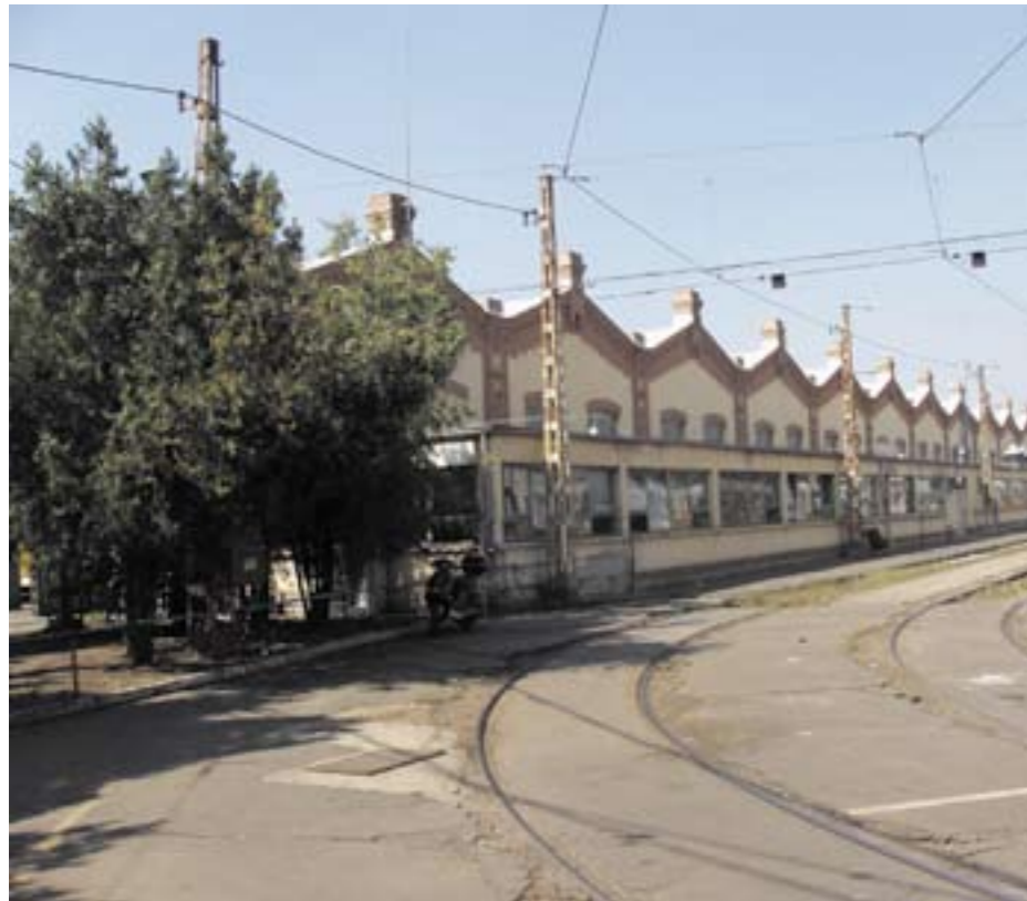
Depo Hungária, pohled na průčelí
