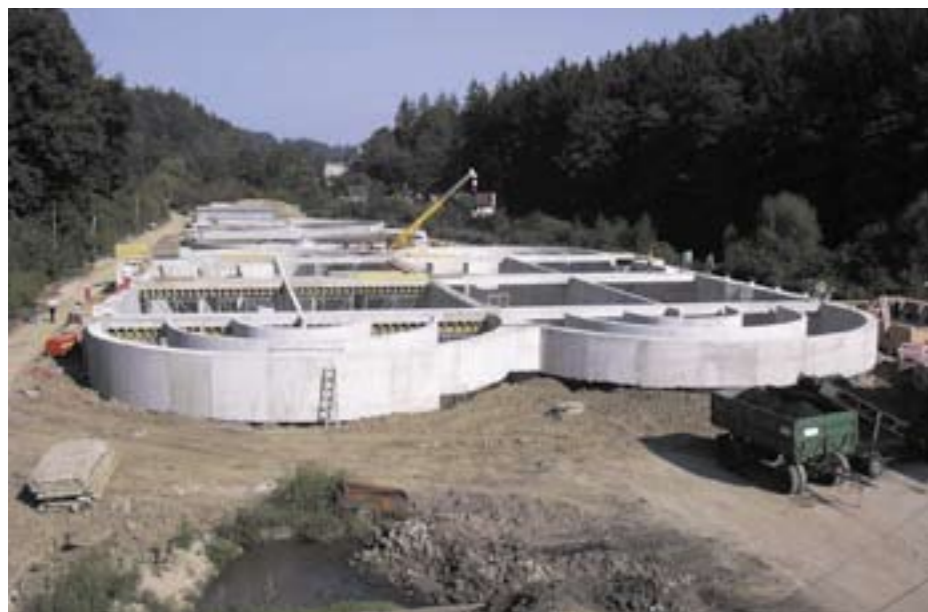
Nové aktivizační a dosazovací nádrže
