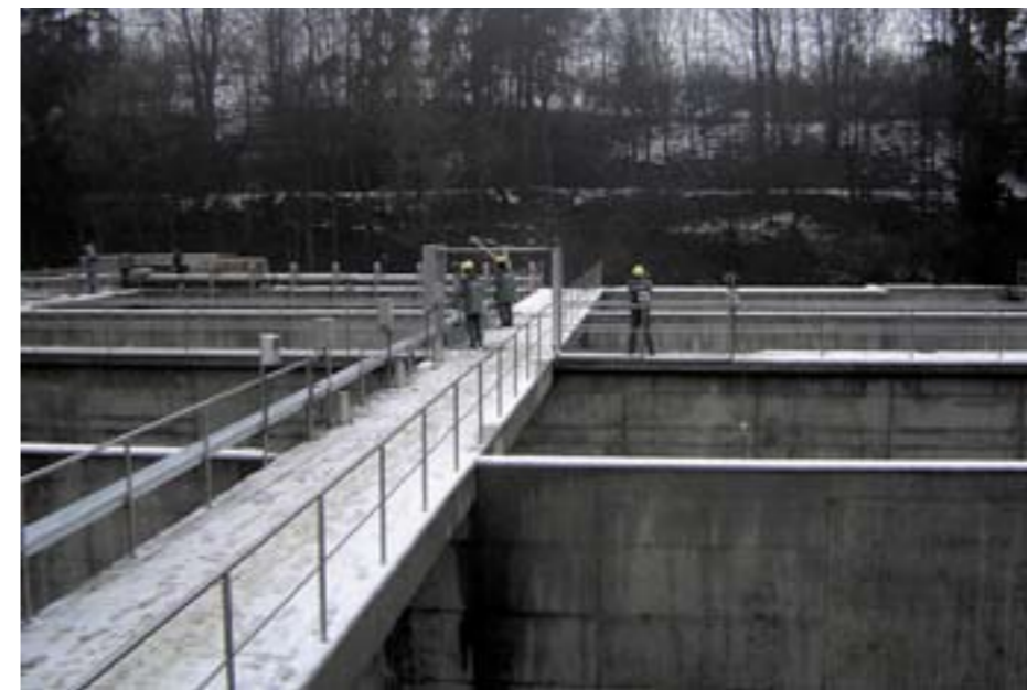
Pohled na aktivaci a dosazovací nádrže
